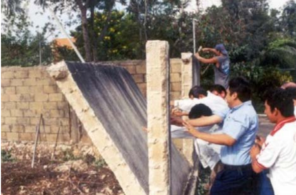
Figura 3. Ampliación del espacio físico del CICY. Demolición de la barda limítrofe (2003).
