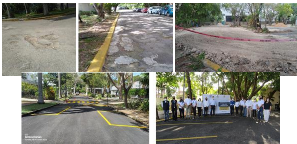
Figura 70. Trabajos de pavimentación.
