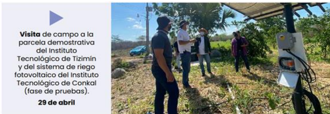
Figura 12. Instalación de sistema de riego fotovoltaico en parcelas demostrativa en Tizimín y Conkal.
