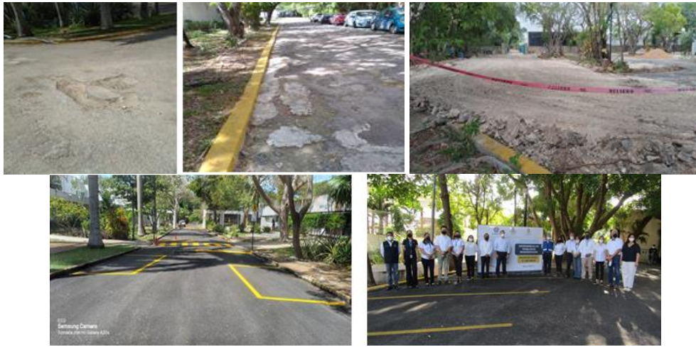
Figura 53. Trabajos de pavimentación.
