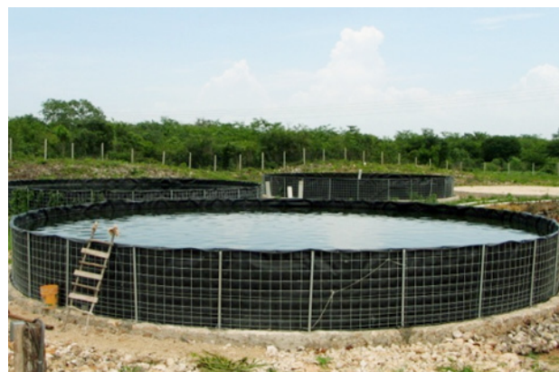
Construcción de depósitos. (Foto: M. Olvera)
