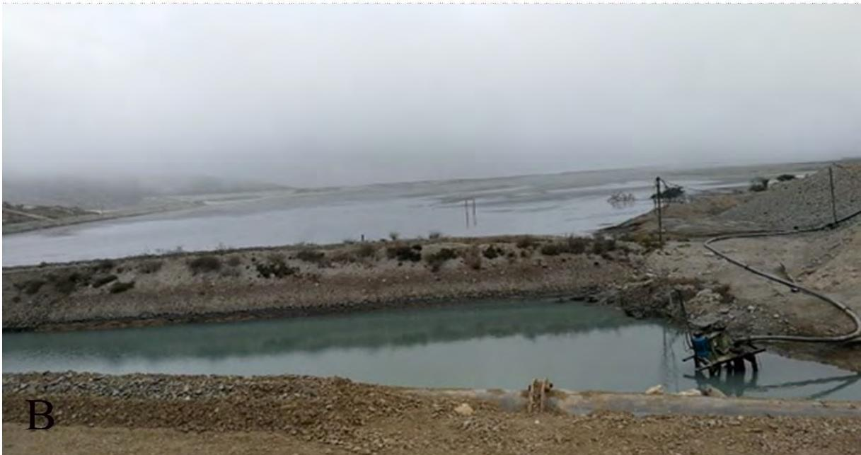
**Figura 2.** Suelo producto de la actividad minera en México. **A.** Jal “Las Presas” en Huautla, Morelos. Se observa el suelo desnudo en gran parte del residuo mineral y el crecimiento de algunas especies arbustivas al fondo. **B.** Presa de jales mineros en la localidad Las Charcas, San Luis Potosí. Se observa el suelo semi-desnudo sobre el residuo mineral. (Fotografías: **A.** Roberto Márquez Huitzil, enero de 2022, **B.** Mario Cayetano Salazar, diciembre de 2020).
