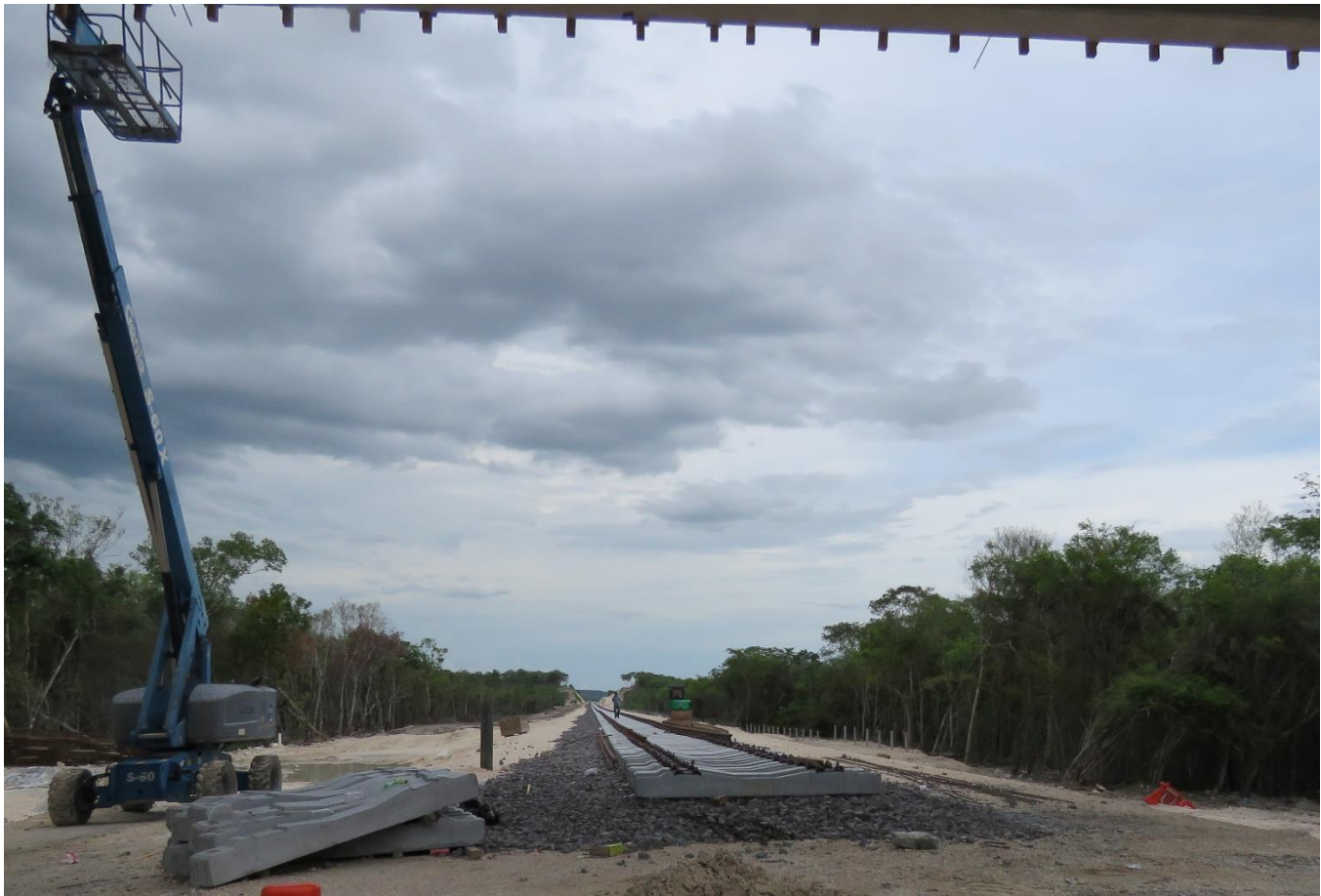
Figura 1. Construcción de las vías del Tren Maya en la Península de Yucatán. (fotografía: Celene Marisol Espadas Manrique).
