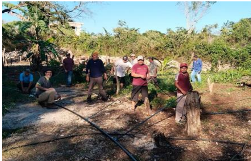
Figura 22. Instalación del Sistema de Riego.
