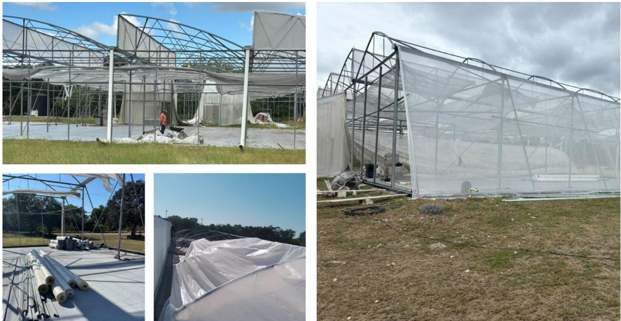
Figura 82. Reparaciones de los invernaderos de la UPS
