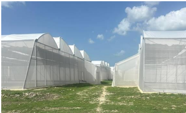
Figura 86. Invernaderos restaurados en la UPS
