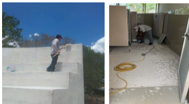
Figura 126. Restauración de la infraestructura del inmueble ubicado en el lote 33930 a cargo de la Dirección del PCTY
