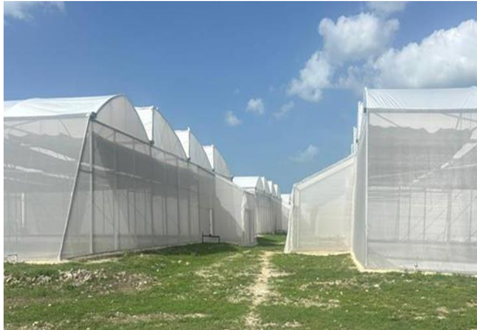
Figura 125. Invernaderos de la UPS restaurados
