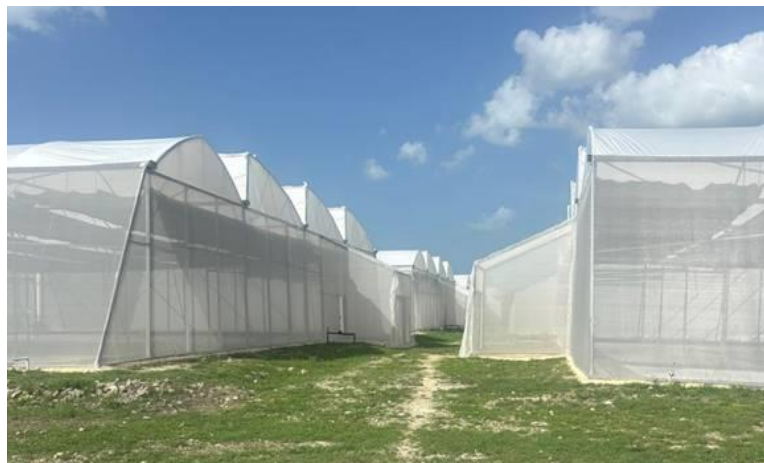
Figura 64. Invernaderos restaurados en la UPS
