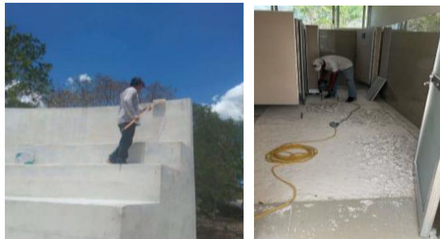
Figura 110. Restauración de la infraestructura del inmueble ubicado en el lote 33930 a cargo de la Dirección del PCTY
