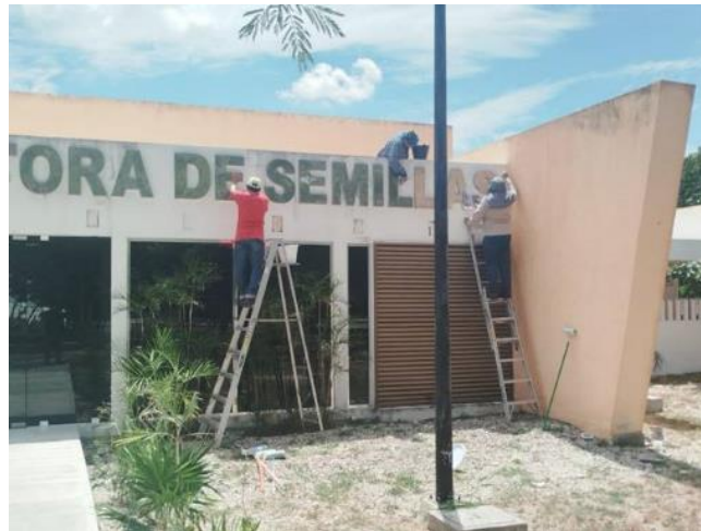
Figura 65. Inicio de los trabajos de pintura de la fachada principal de la UPS.
