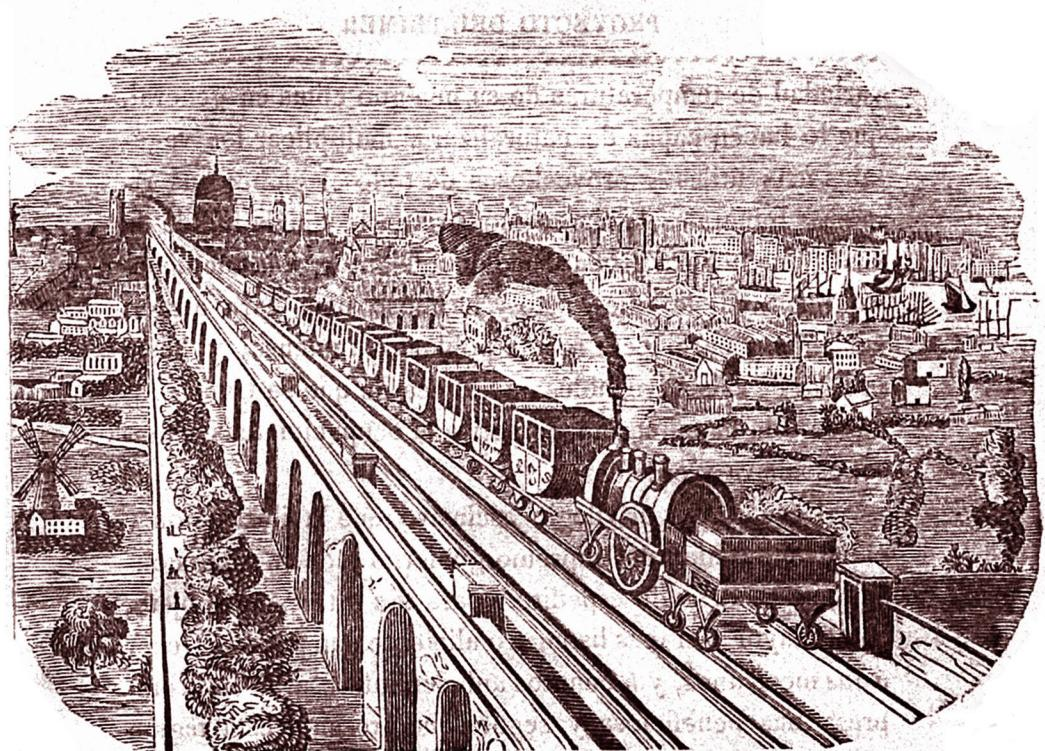
(Esta viñeta representa un tren de primera clase y en movimiento, tirado por una máquina locomotora por la linea derecha; y á alguna distancia se divisa otro tren en la linea izquierda yendo á Londres. Por la parte baja se ve la forma de la arcada sobre la que está nivelado el ferro-carril.)
